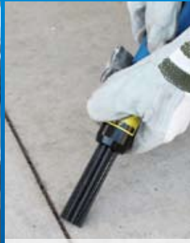
コンクリートの目荒らし
