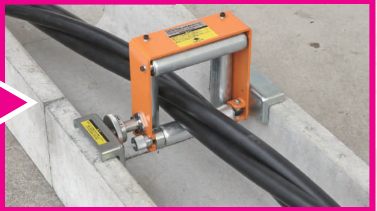
ケーブルトラフコロ使用時
