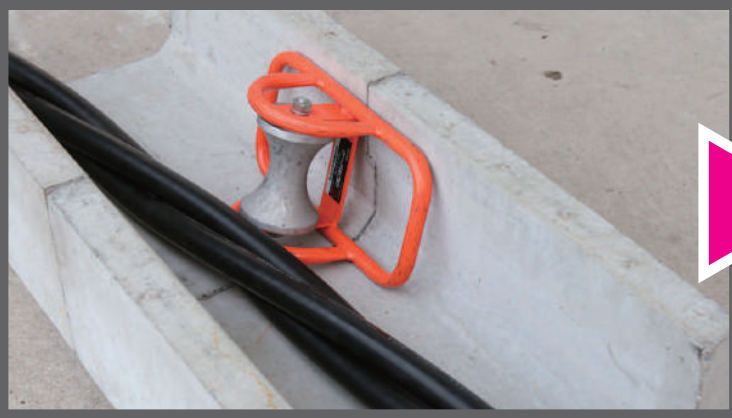
これまでの敷設現場
